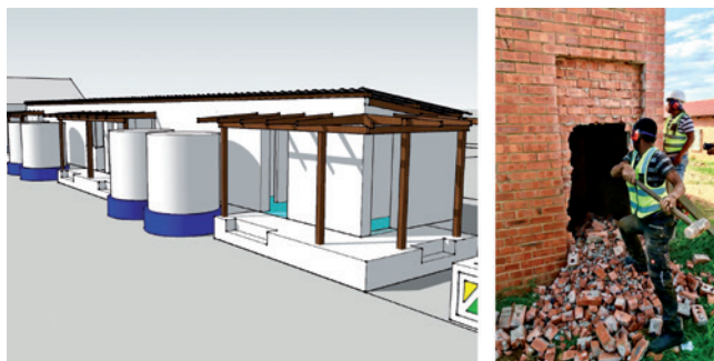
Geplante Veränderungen der sanitären Anlagen und erste Bauarbeiten vor Ort, Projektschule 2. (Quelle: Jacques Theron & Kevin Kimwelle, Port Elizabeth, Südafrika)
